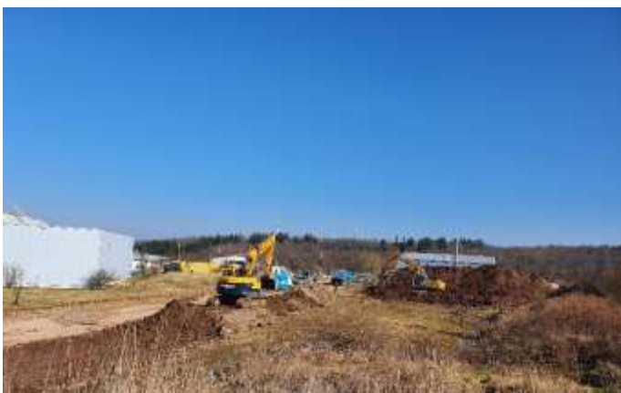
Die Bauarbeiten für unsere neue Großhandels Halle im Gewerbegebiet Konken haben begonnen
