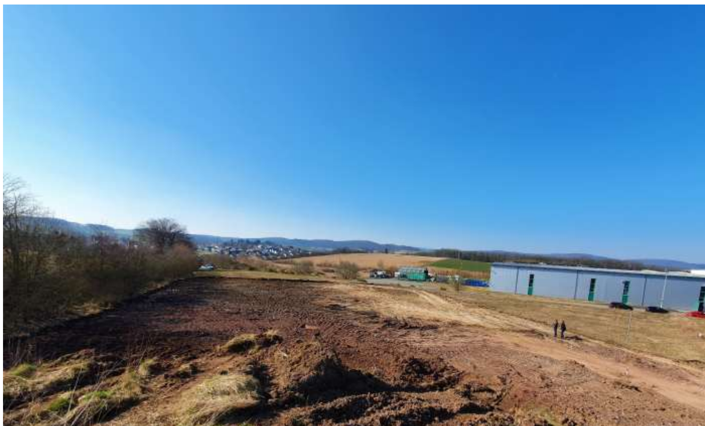
Hier entsteht die 1600 m 2 große Logistikhalle mit Büros und LKW-Wartungshalle
